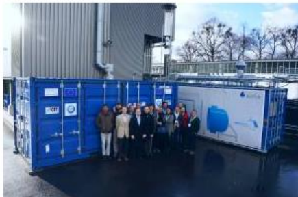
Die Demonstratoranlage des Projekts HELMETH verbindet Methanisierung (links) und Elektrolyse (rechts) mit einem Wirkungsgrad von 76 Prozent. (Bild: sunfire GmbH)
